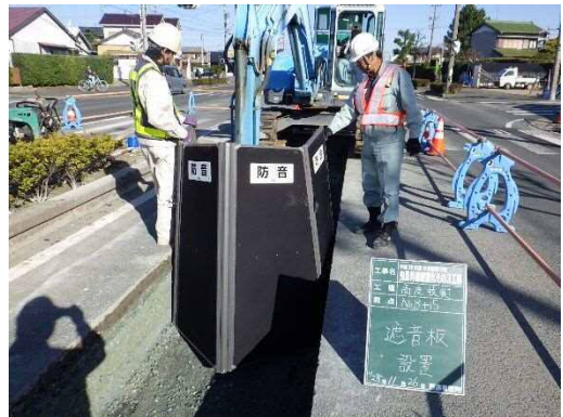
防音パネルの設置
